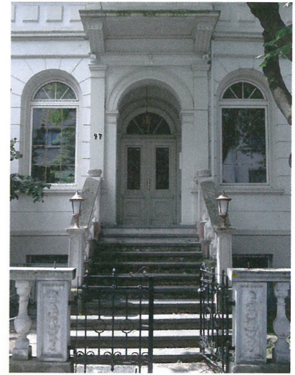
Abb. 6 Hauseingang und Fensterbestand, am Beginn der Sanierungsmaßnahme, 2009
