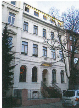
Abb. 4 Straßenfassade, mit erneuerter Einfriedung, 2012
